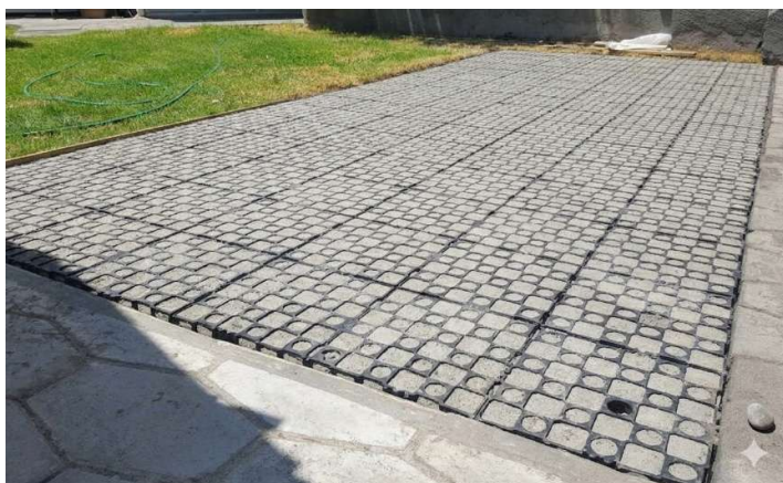
Relleno con hormigón
