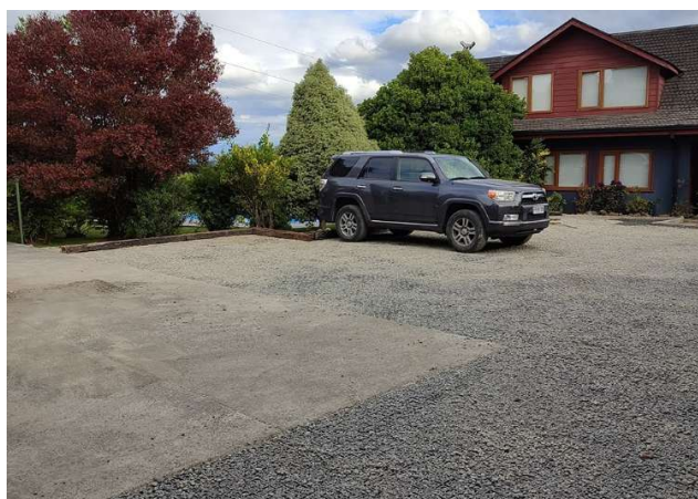
Relleno con grava
